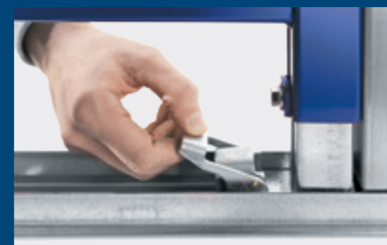
↑ ... a nakonec zajistěte lištovými svorkami Geberit Duofix.
