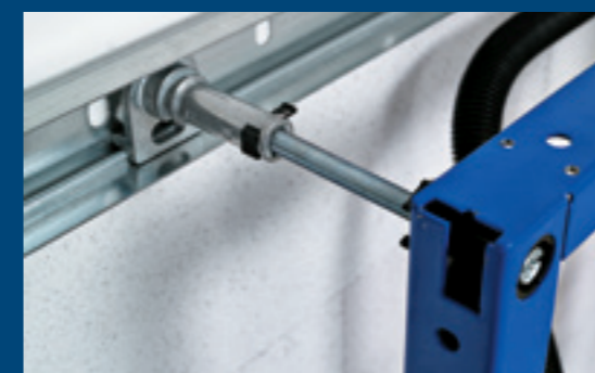
↑ Umístěte montážní prvek Geberit Duofix do správné pozice. U předstěnové instalace na částečnou výšku místnosti ho ukotvěte pomocí montážní soupravy Geberit...
